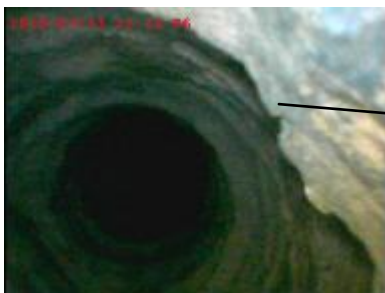
Abbildung 4: vor der chemisch- mechanischen Reinigung
