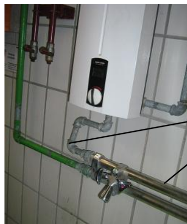
Abbildung 6: verzinkte und edelstahl Rohre mit Durchlaufhitzer
