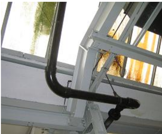
Abbildung 5: Verlauf der Kunststoffrohre
