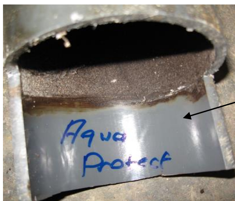
Abbildung 15: PVC Rohrreinigung mit Aqua Protect System
