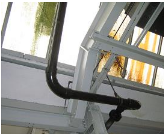
Abbildung 5: Verlauf der Kunststoffrohre
